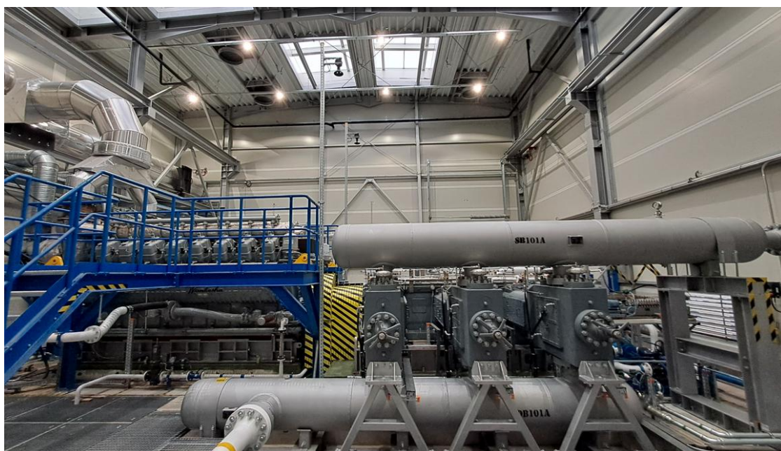
1. sz. kép – ZSA 2025. évben telepített, új gázmotoros meghajtású kompresszora
